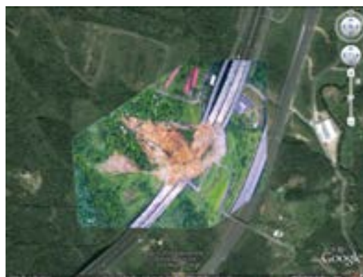
(b) 崩塌地套疊Google earth比對 圖18 UAV辦理北二高山坡護體崩塌成果
